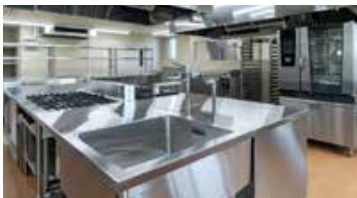
Fabrication de cuisines
